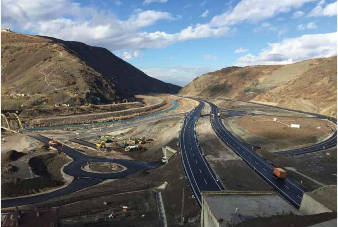
Erzincan Pülümür Ayrımı Devlet Yolu İnşaatı, Özdemir İnşaat A.Ş.
