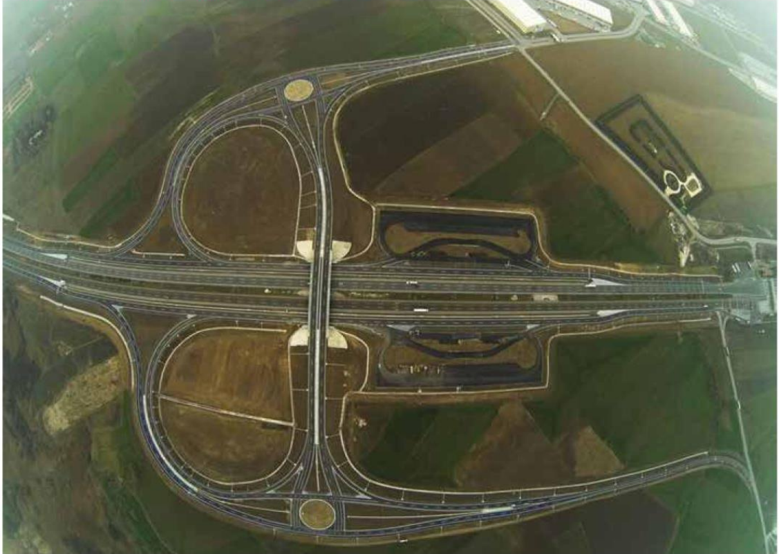
Ankara-Gerede Anadolu Otoyolu; Kazan Bağlantı Kavşağı Yapımı, Onur Taahhüt A.Ş.
