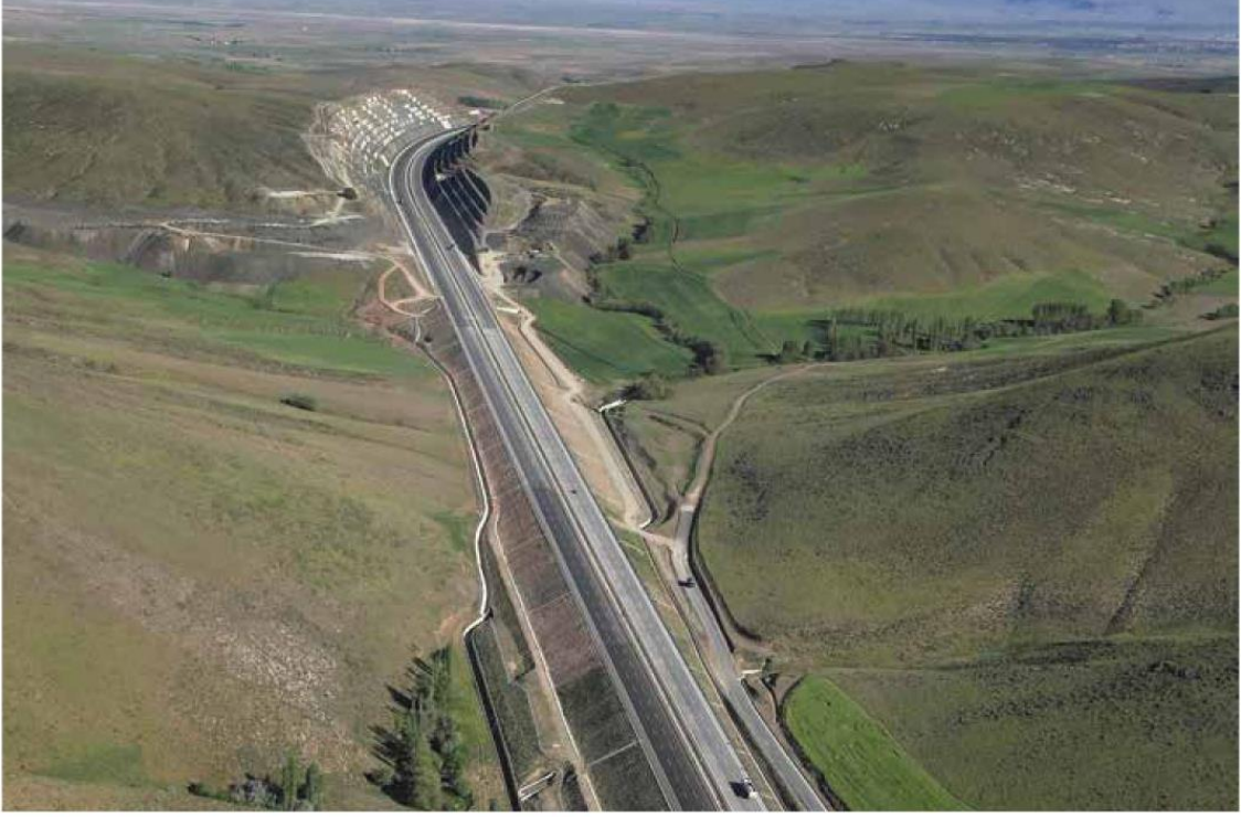
Kemerhisar-Pozantı Otoyolu, Gölcük - Kemerhisar Kesimi, Kolin İnşaat A.Ş.
