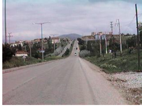
Kırşehir'den geçen 765 nolu yol, güney kısım
