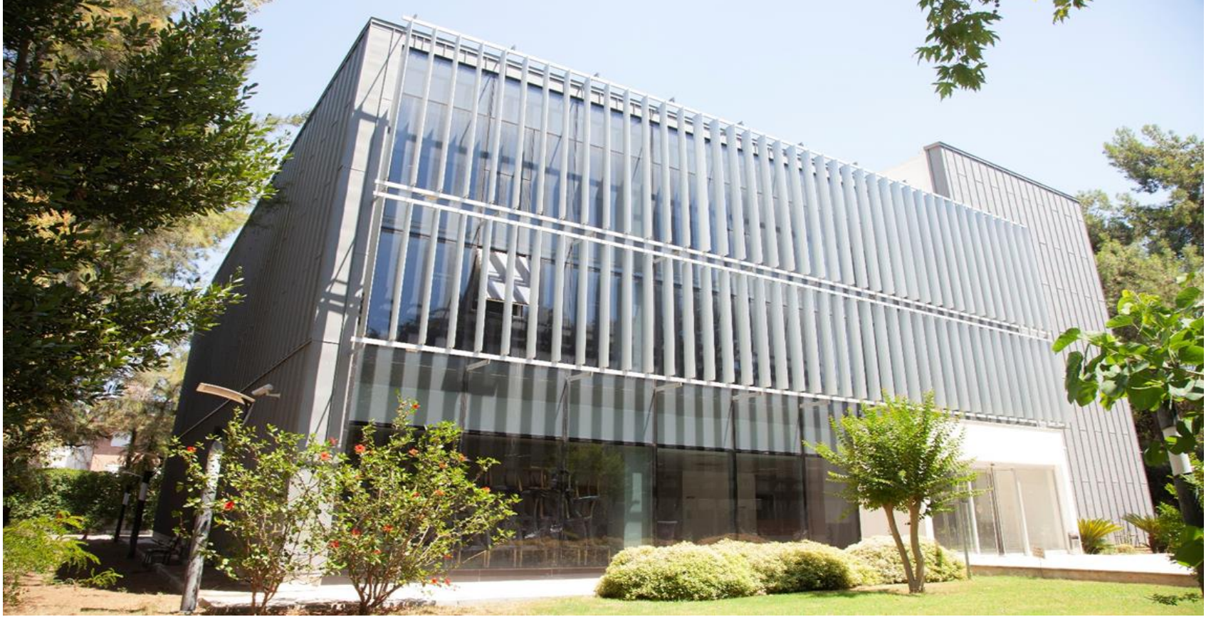
Karayolları 13. B¼lge (Antalya) AUS Merkezi Binası
