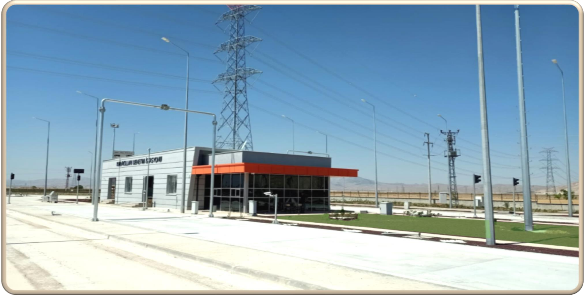
Karayolları Denetim İstasyonu Tesisi - Karaömerler
