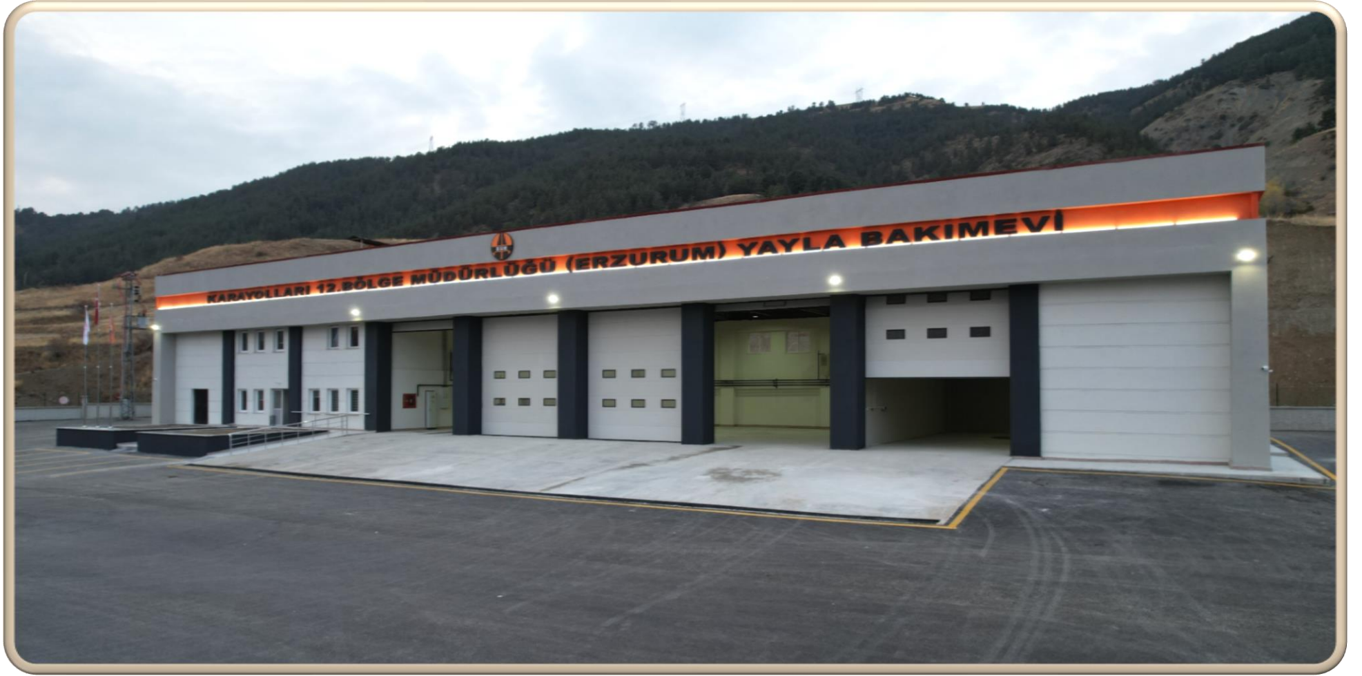
Karayolları 122. (Erzurum) Ŗube Ŗefliđi Yayla Bakımevi Binası
