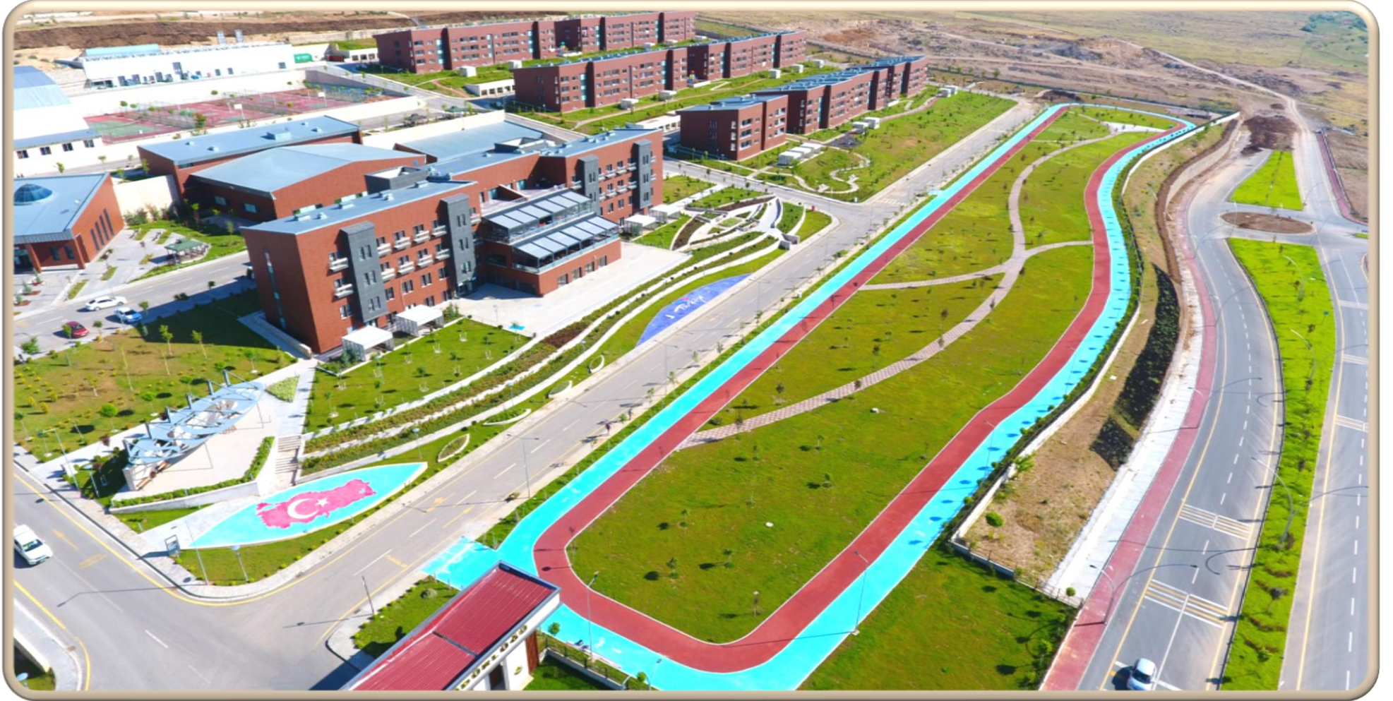
11. (Van) Bölge Müdürlüğü Tesis Binaları
