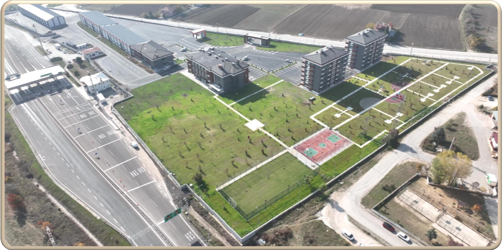
4. Bölge Müdürlüğü 41. (Bolu) Ŗube Ŗefliđi Tesis Binaları
