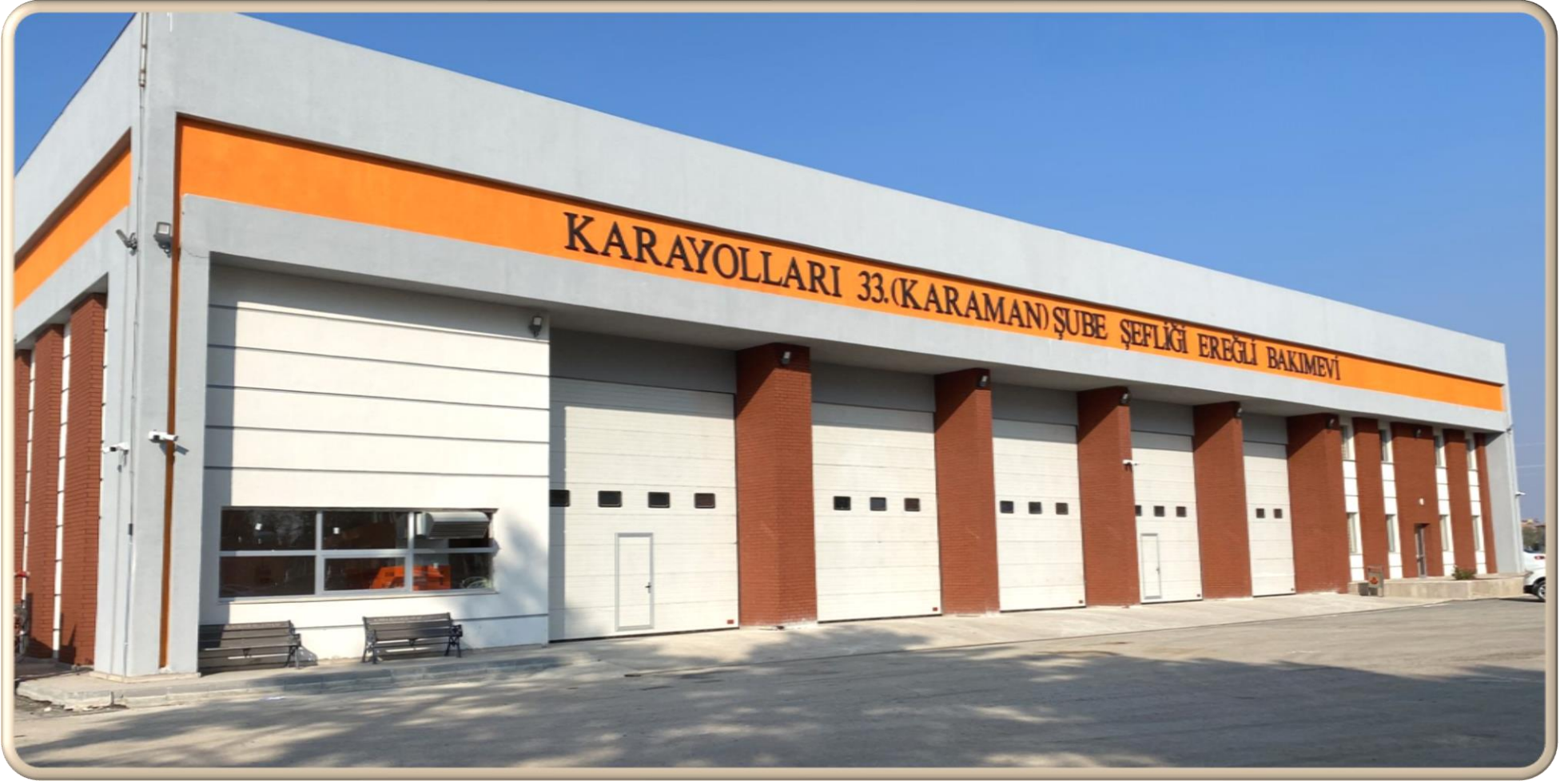
Karayolları 33. (Karaman) Ŗube Ŗefliđi Eređli Bakımevi Binası
