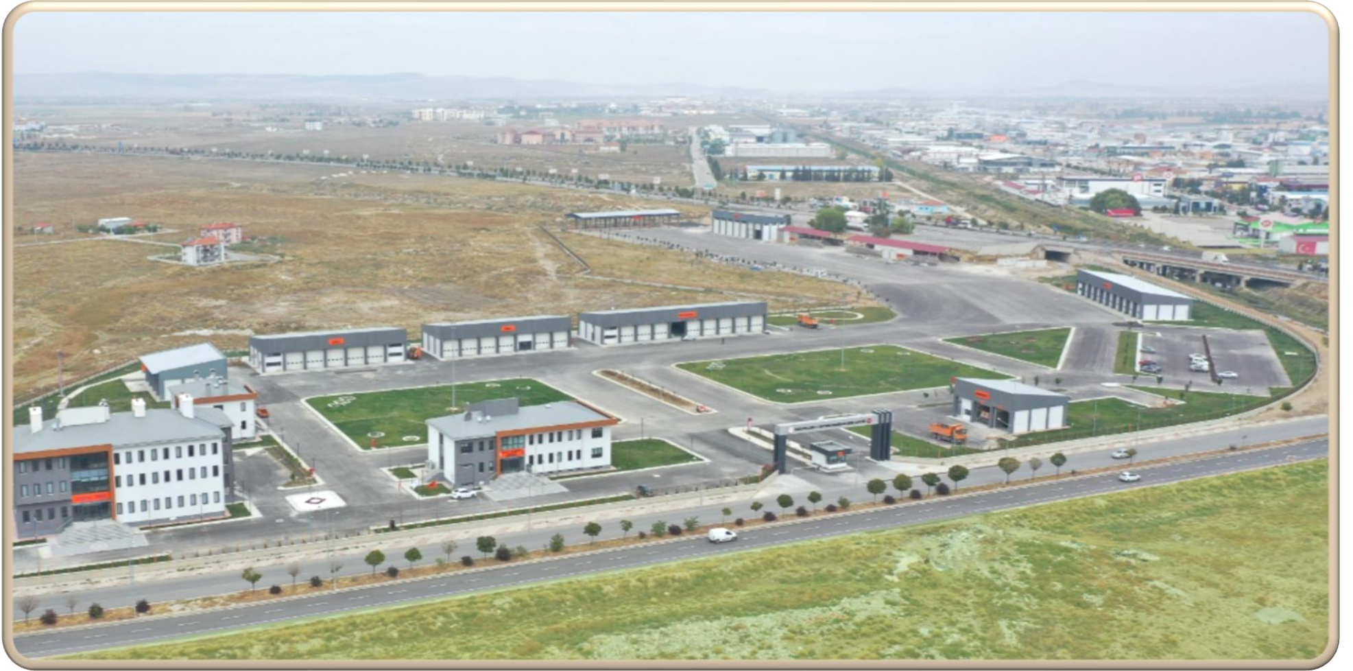
3. Bölge Müdürlüğü 31. (Afyon) řube řefliđi Tesis Binaları
