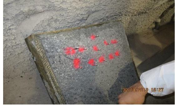
Resim 9.4 Saplamanın Çakılması
