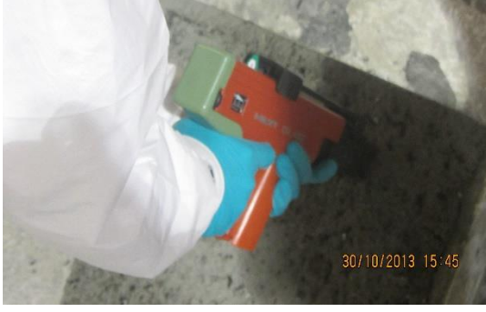
Resim 9.4 Saplamanın Çakılması
