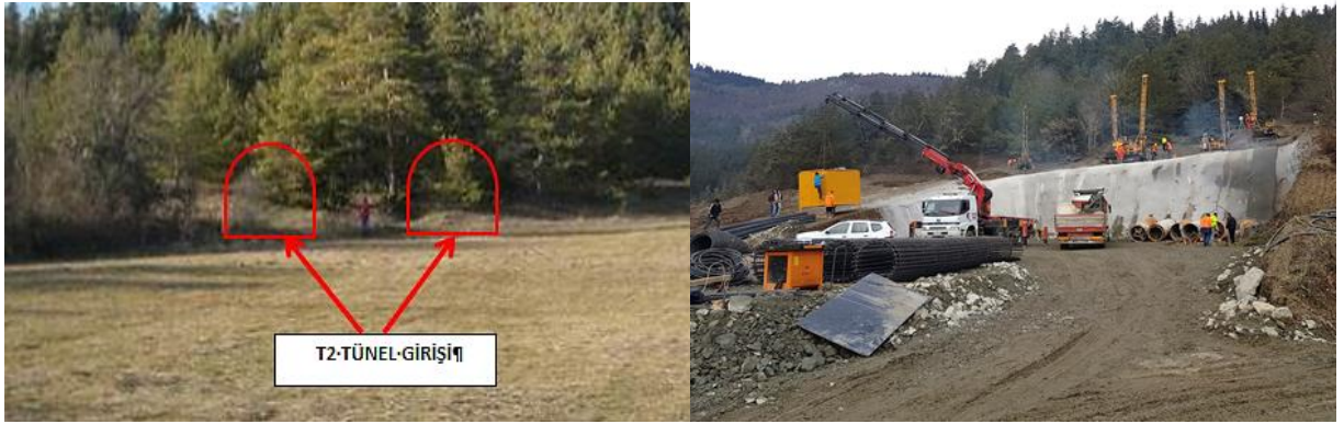
T-2 Tüneli Giriş Portalindeki Yapım çalışmaları
