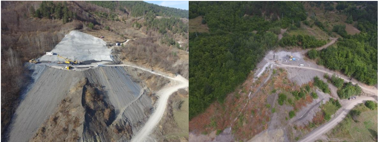
Tünel çıkış portalinden görünüm
