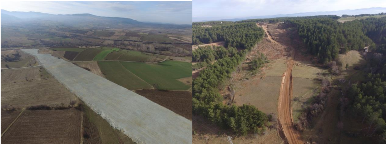
Güzergahta devam eden yapım çalışmalarından görünüm
