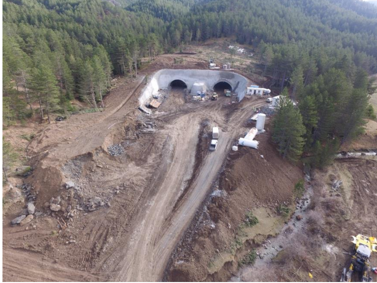
Tünel giriş portalinden görünüm
