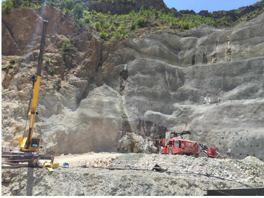
T-39 tünelinin revize portalininin destekleme çalışmaları
