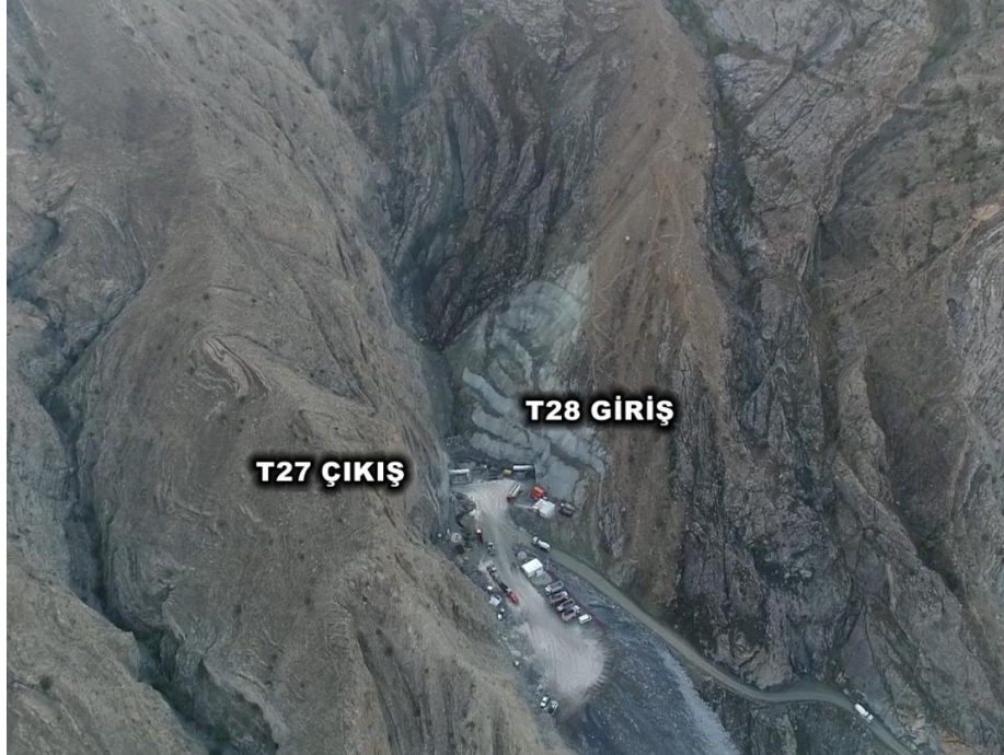
Sahada gerçekleştirilen portal imalat çalışmaları
