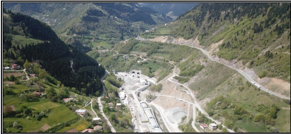
Yeni Zigana Tüneli giriş portalı
