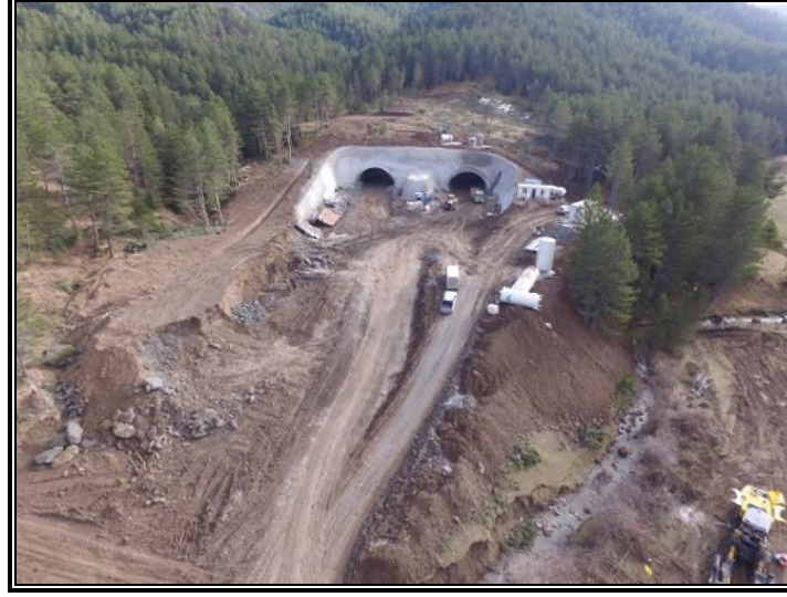
Tünel giriş portalinden görünüm
