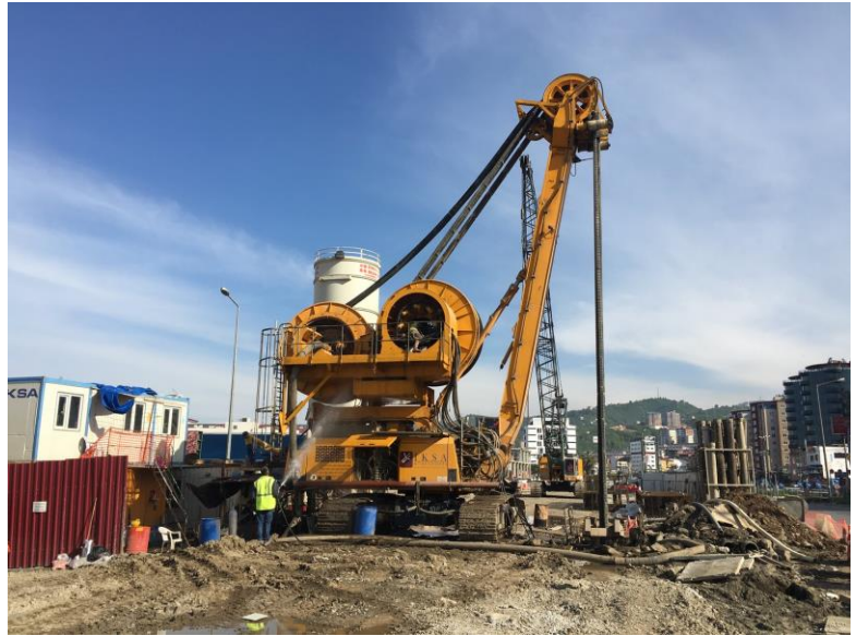
Diyafram duvar imalatından görünüm.
