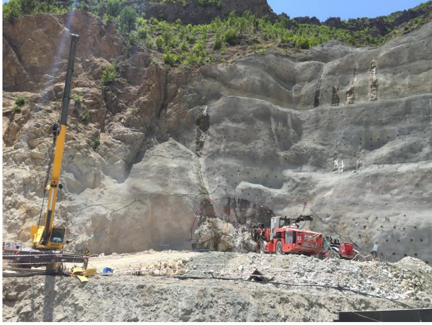
T-39 tnelinin revize portalininin destekleme alıřmaları
