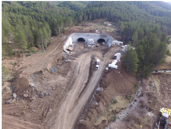
Tünel giriş portalinden görünüm
