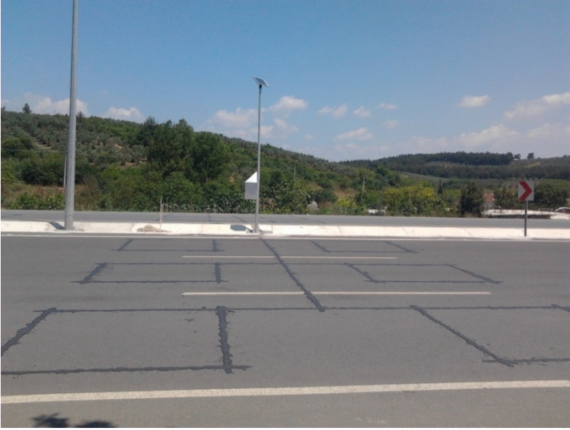
Şekil 3.1.1. Manyetik Döngülü Otomatik Trafik Sayım Sistemi
