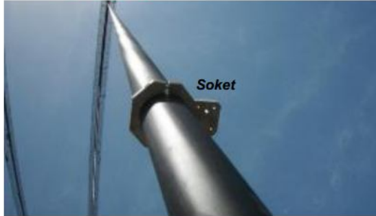
Fig.- 2.26 Mobil İvme Ölçerler İçin Soket Lokasyonları ve Mobil İvme Ölçer
