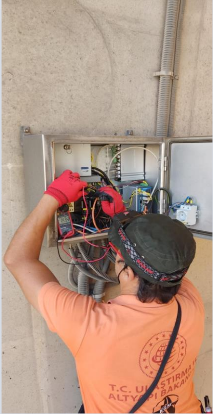
Kamera Sistemi Aylık Bakımı
