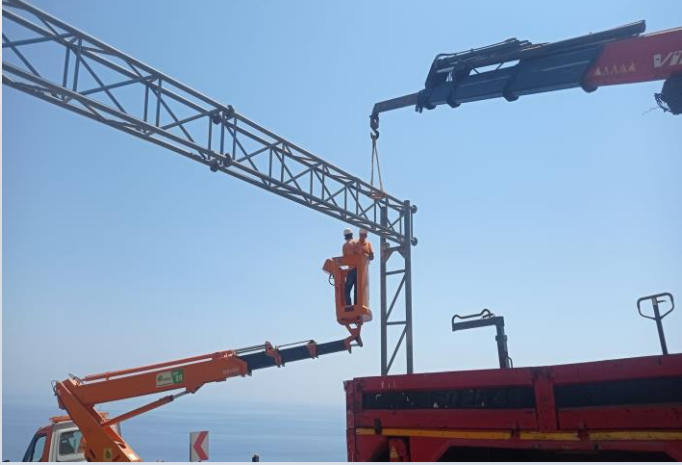
Mekanik Gabari Montajı
