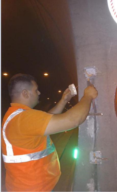
Hatalı Sinyal Bağlantı Kontrolü
