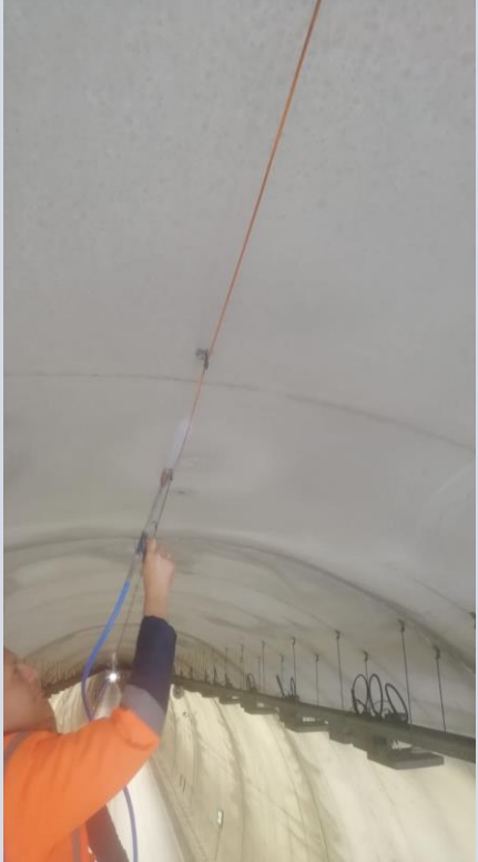
Doğrusal Yangın Algılama Sistemi Aylık Bakımı
