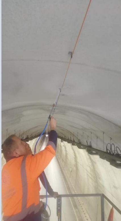
Doğrusal Yangın Algılama Sistemi Aylık Bakımı
