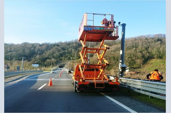
Kamera Sistemi Aylık Bakım ve Kontrolü
