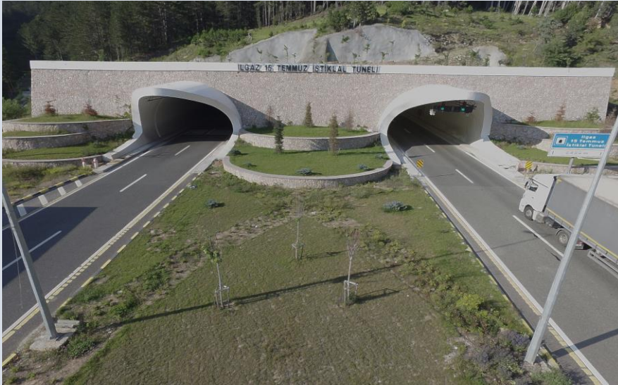
Ilgaz 15 Temmuz İstiklal Tüneli
