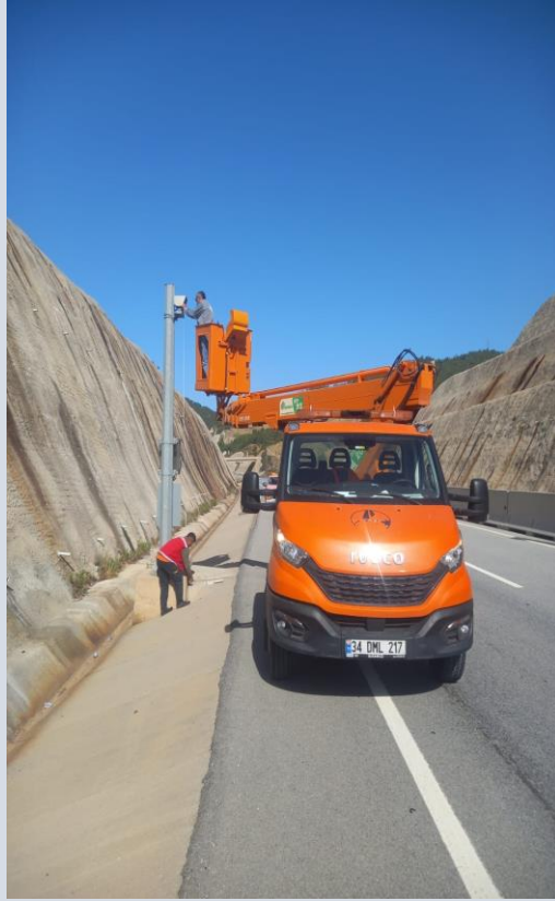
Elektronik Gabari Sistemi 6 Aylık Bakımı
