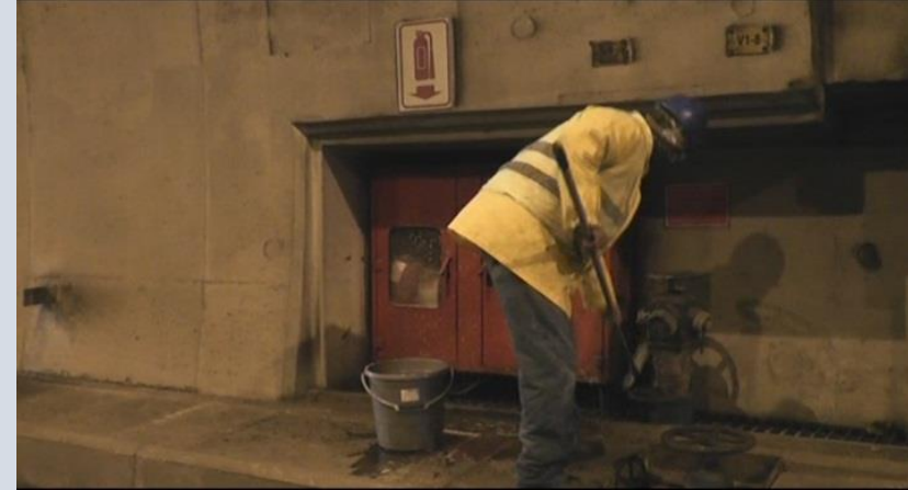
Tesisat Kanalı Temizliği
