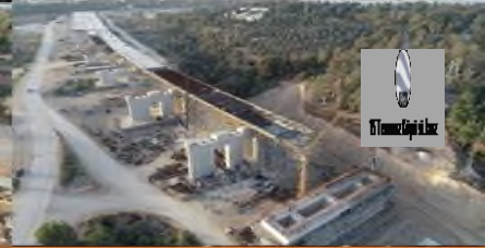
P7 - P14 SOL KARAYOLU ARDGERME DÖŞEME İMALATI
