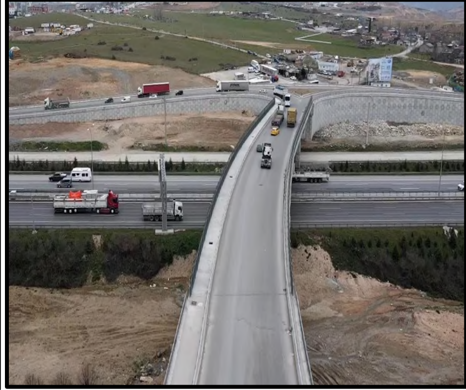
Bađlantı Yolu 4 Köprüsü
