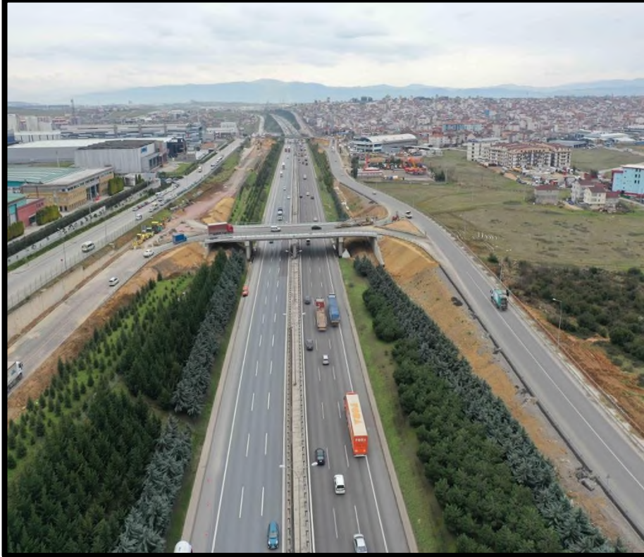
Bađlantı Yolu 1 Köprüsü
