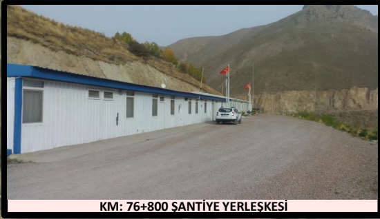
KM: 76+800 ŞANTİYE YERLEŞKESİ
