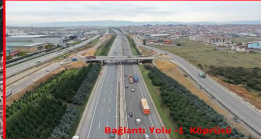
Bağlantı Yolu-1 Köprüsü
