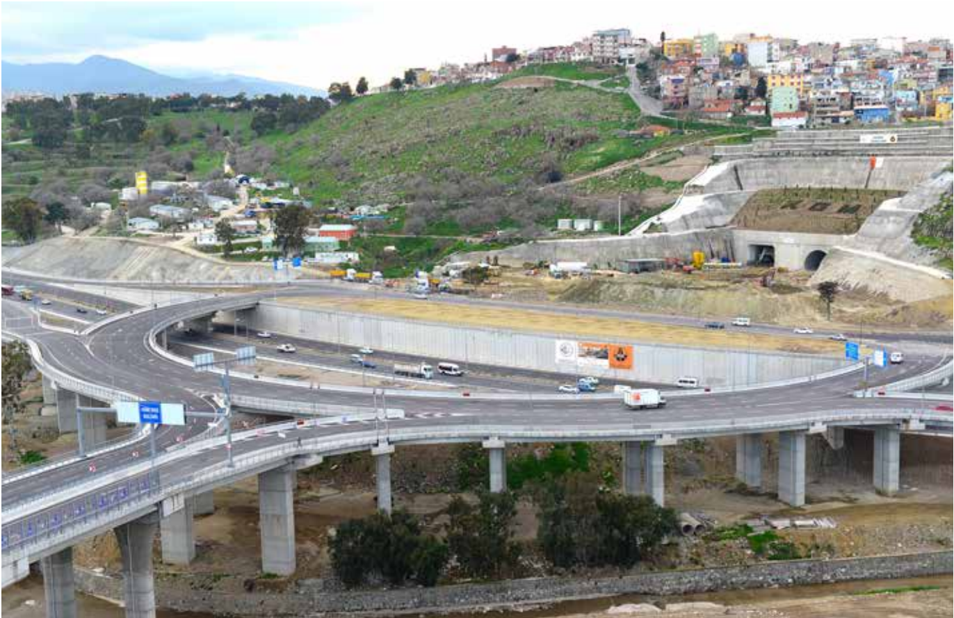
İzmir-Konak Tüneli-Yeşildere Koprülü Kavşağı
