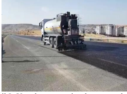
Şekil 3. Uygulama öncesi tack coat yapılması.
