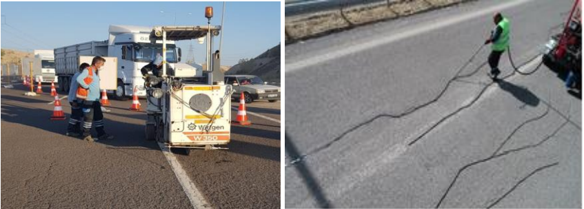
Şekil 2. Yol çizgilerinin kaldırılması ve çatlak tamir çalışmaları.
