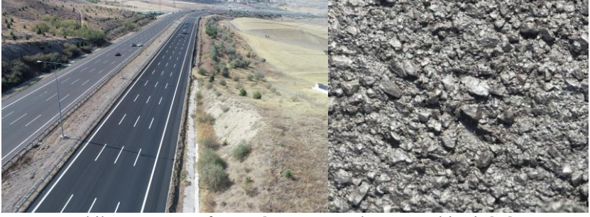
Şekil 7. Micro Surfacing deneme uygulamasının bitmiş hali.
