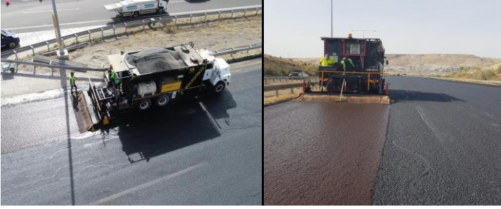
Şekil 4. Micro surfacing deneme uygulaması.
