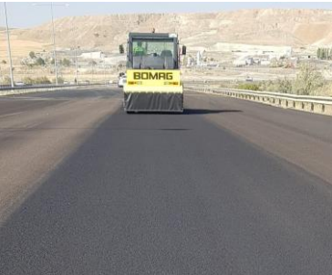
Şekil 5. Silindirme işlemi.
