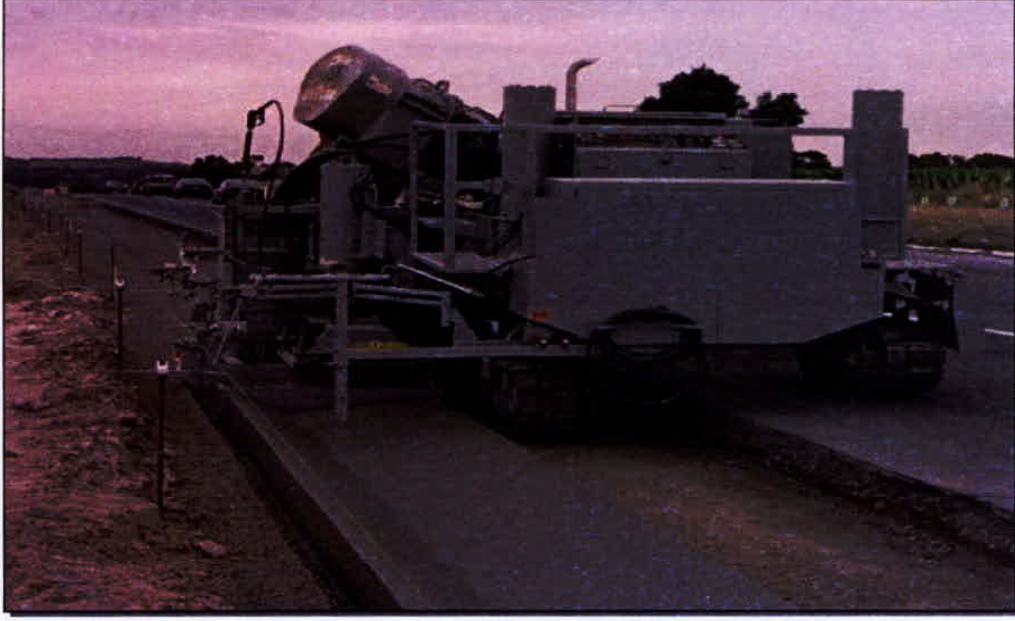
Makinalı Beton Hendek İmalatından Görünüm
