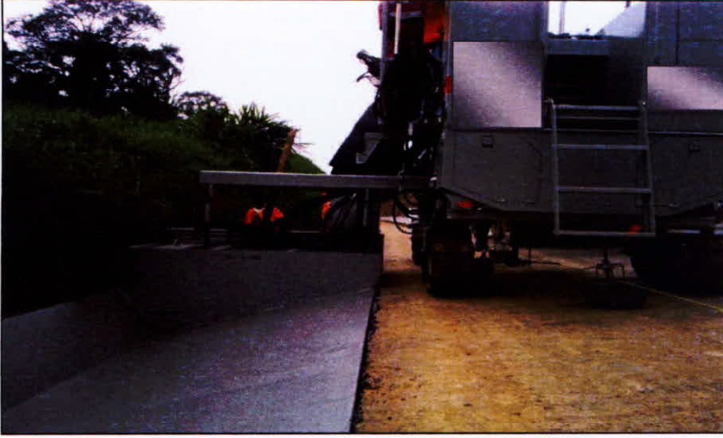
Makinalı Beton Hendek İmalatından Görünüm
