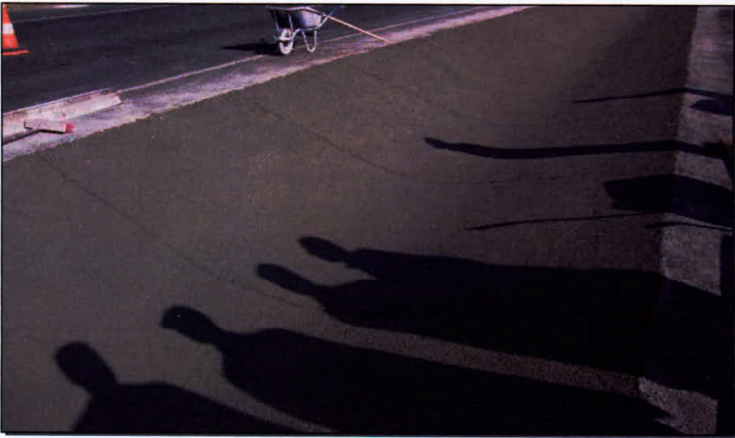
Tamamlanmış Beton Hendek İmalatından Görünüm
