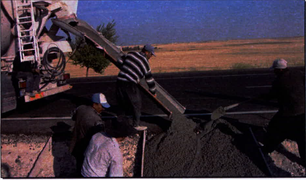
El ile Beton Hendek İmalatından Görünüm
