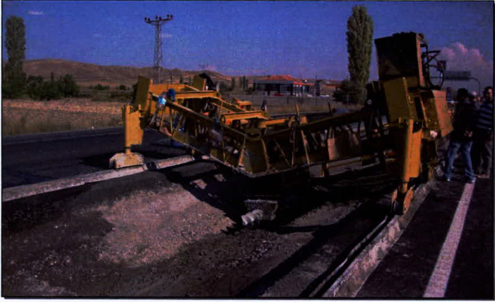
Makinalı Beton Hendek İmalatından Görünüm
