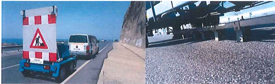
Şekil.4:Yüksek Ağırlıklı Deflektometre İle Defleksiyon Ölçüm Çalışmaları
