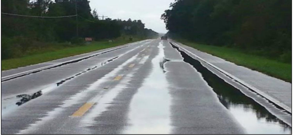
Şekil 14: Tekerlek İzinde Oturma Bozulmasına Sahip Yol Örneği
