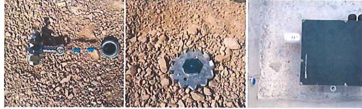
Şekil 8. Düşey deplasman sensörüne ait çelik telin geçeceği kanalın temel tabakası yüzeyine kadar olan kısmının yerleştirilmesi ve düşey deplasman sensörüne ait telin temel tabakası yüzeyine sabitlenmesi
