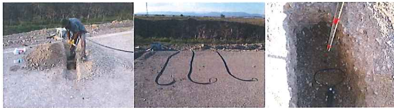
Şekil 11. Sıcaklık sensörlerinin montaj işlemlerinin yapılması (Kaplama tabakasına yerleştirilen sıcaklık sensörleri kaplama tabakası kesilerek ara yüzeyine yerleştirilmiştir)
