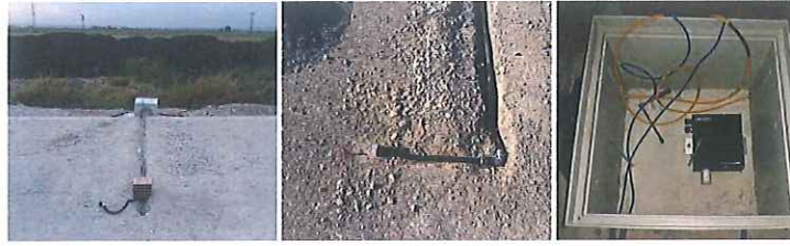
Şekil 9. Yatay deplasman sensörlerine ait çelik tellerin geçeceği kanalların montajlarının yapılması ve çelik telin yüzeye sabitlenmesi
