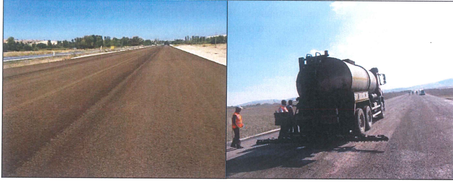
Şekil-9: Konya (3. Bölge Müdürlüğü) uygulama fotoğrafları
