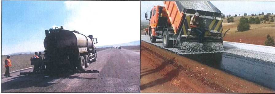
Şekil-2: Astar bağlayıcı ve sathi kaplama uygulaması
