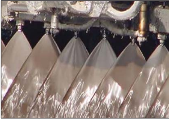
Şekil 6.4. Karartma Tabakası (Fog Seal) Uygulaması
