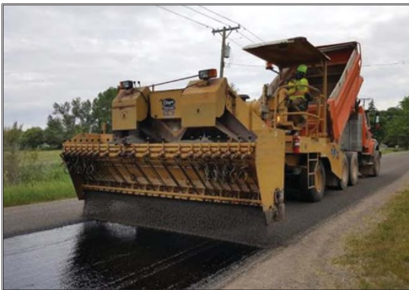
Şekil 6.9. Seal Coat Uygulamasında Agregaya Serimi
