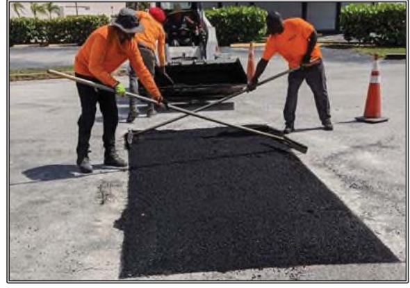
Şekil 5.9. Yama Malzemesinin Yerleştirilmesi
