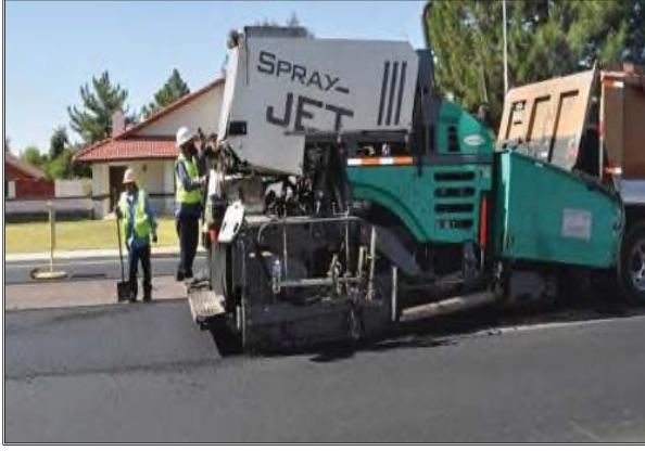
Şekil 6.29. Çok İnce Takviye Aşınma Tabakası (UBWC) Uygulaması
