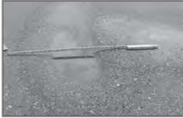
Şekil 3.10. Oturma veya Çökme (Settlement or Depression)
