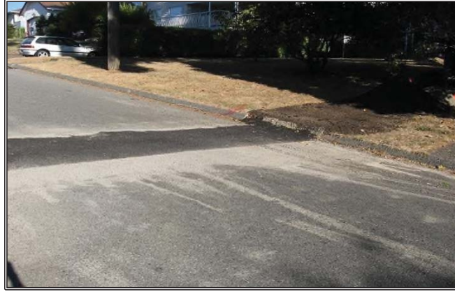
Şekil 3.12. Enine Geçiş ve Yama (Utility Cuts and Patch)
