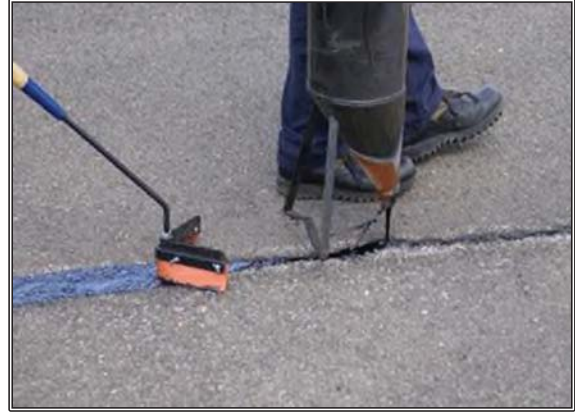
Şekil 5.2. Çatlak Kapama Ekipmanları; Basınçlı Aplikatör ve Serbest Dökme Kabı
