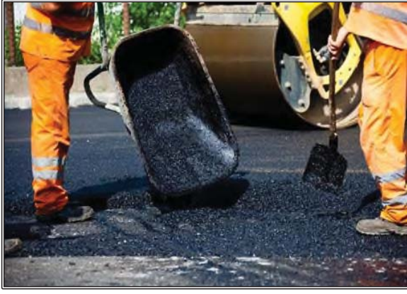
Şekil 5.9. Yama Malzemesinin Yerleştirilmesi
