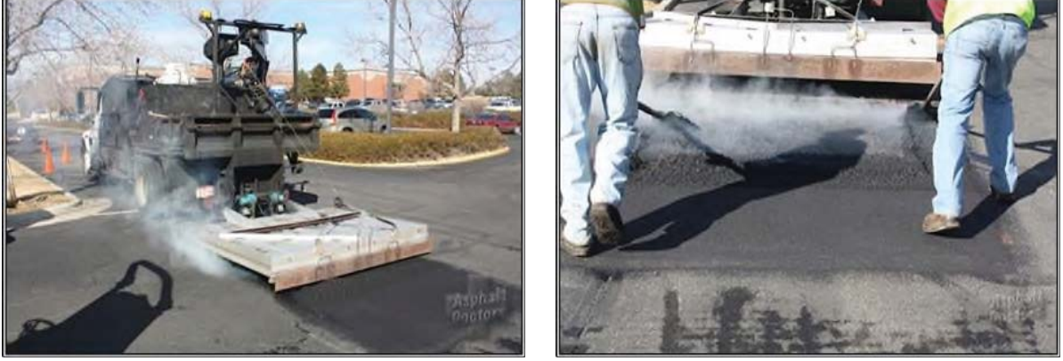
Şekil 5.15. İnfrared Isıtıcı Yama Uygulaması
