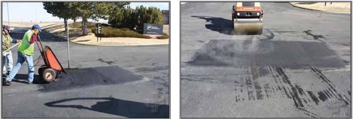
Şekil 5.16. İnfrared Isıtıcı Yama Uygulaması
