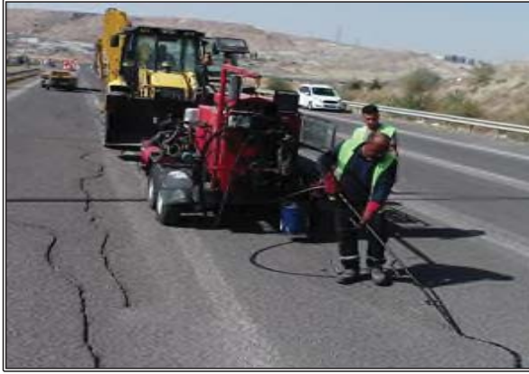
Şekil 5.2. Çatlak Kapama Ekipmanları; Basınçlı Aplikatör ve Serbest Dökme Kabı
