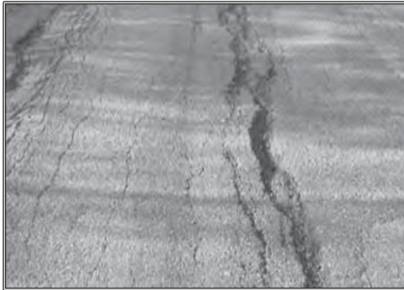
Şekil 3.11. Kabarma veya Şişme (Upheaval or Swelling)
