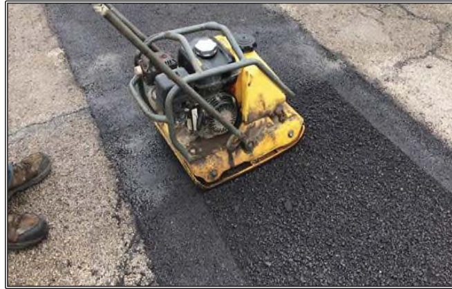
Şekil 5.10. Titreşim Plakalı Sıkıştırıcı ile Yama Malzemesinin Sıkıştırılması
