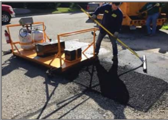
Şekil 5.14. İnfrared Isıtıcı Yama Uygulaması
