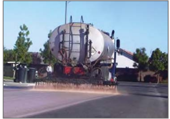
Şekil 6.4. Karartma Tabakası (Fog Seal) Uygulaması
