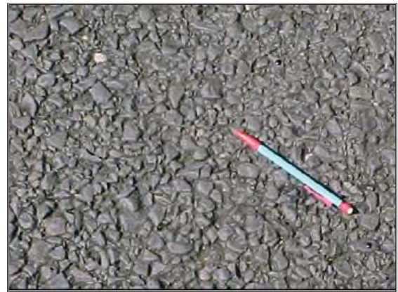
Şekil 6.7. Bitüme Bulanmış (Prekote) Agreganın Stoklanması ile Uygulama Sonrası Yüzey Görünümü
