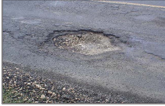
Şekil 3.13. Çukur (Pothole)
