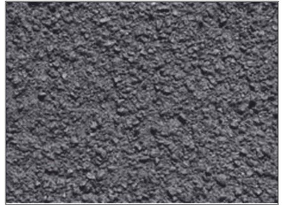
Şekil 6.13. Bitüm Emülsiyonlu Harç Tipi Slurry Seal Kaplama Uygulaması
