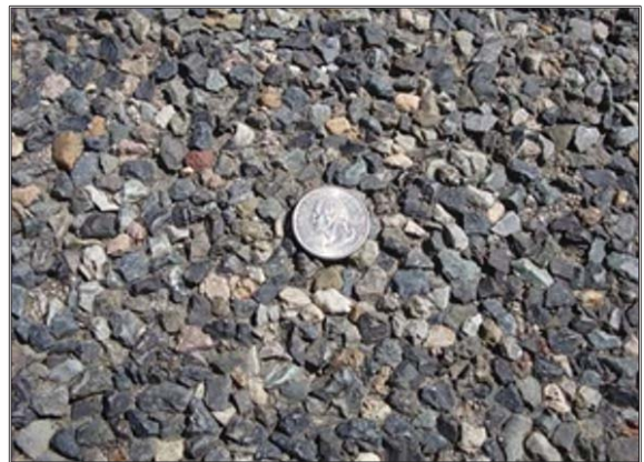
Şekil 6.9. Seal Coat Uygulamasında Agregaya Serimi
