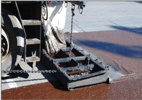
Şekil 6.13. Bitüm Emülsiyonlu Harç Tipi Slurry Seal Kaplama Uygulaması
