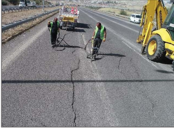
Şekil 6.19. Harç Tipi Kaplama Uygulaması Öncesinde Çatlak Tamirâtı ve Tack Coat Uygulaması
