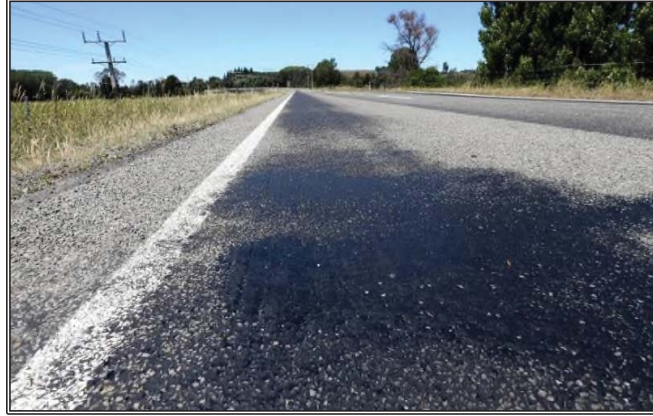
Şekil 3.16. Kuma veya Parlama (Bleeding or flushing)
