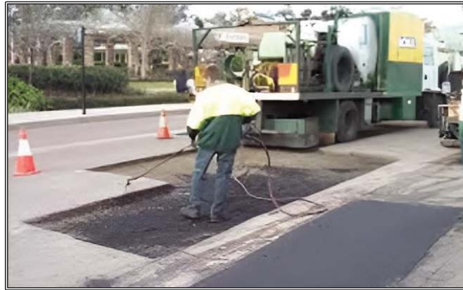
Şekil 5.8. Yapıştırıcı Uygulaması
