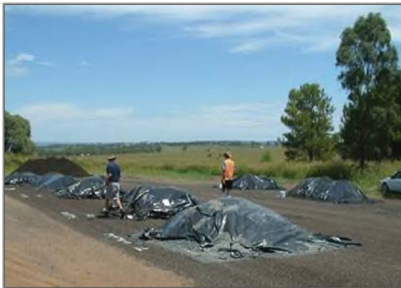
Şekil 6.7. Bitüme Bulanmış (Prekote) Agreganın Stoklanması ile Uygulama Sonrası Yüzey Görünümü
