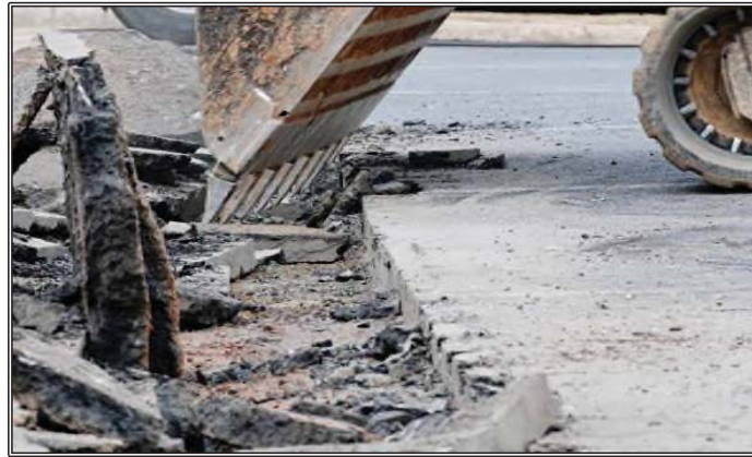
Şekil 5.7. Yama Yapılacak Kaplama Tabakasının Kaldırılması
