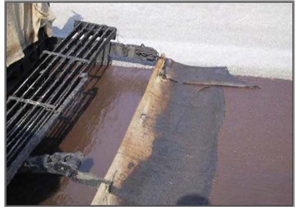
Şekil 6.24. Slurry Seal Yayma Kutusunda Esnek Sıyırma Aparatı ve Kumaş Uygulaması
