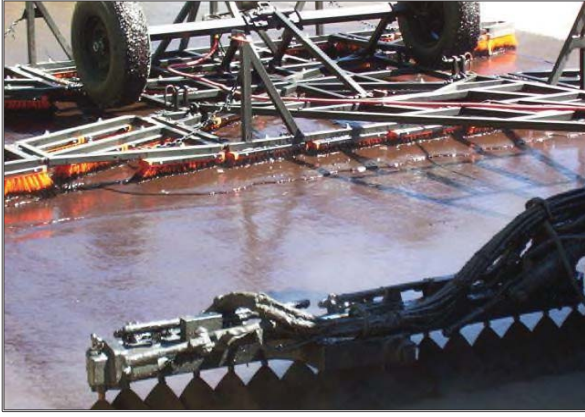
Şekil 6.8. Fırçalamayla Yalıtım (Scrub Seal) Uygulaması
