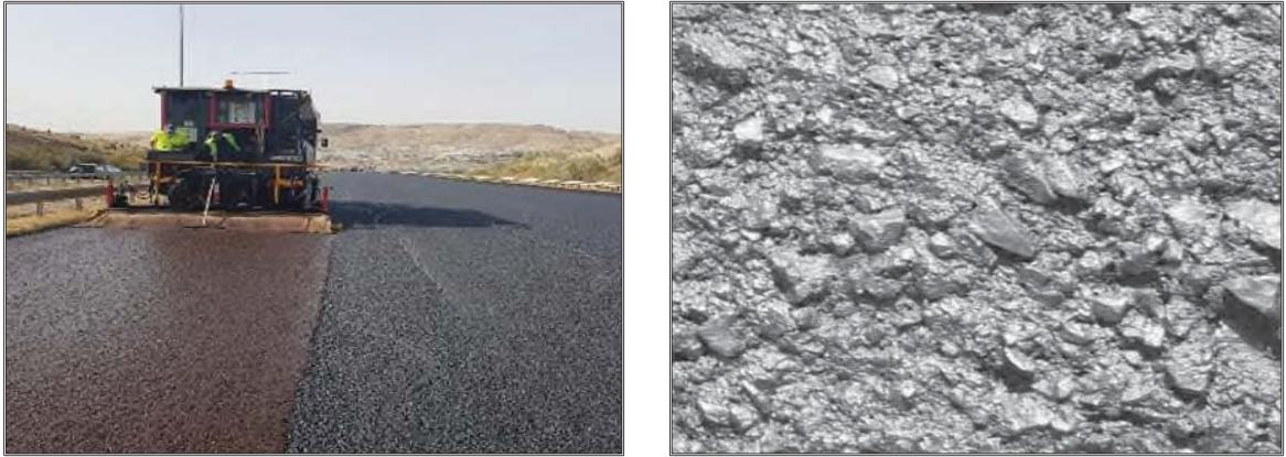
Şekil 6.25. Micro Surfacing Uygulaması
