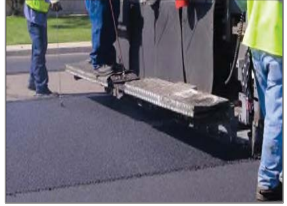
Şekil 6.29. Çok İnce Takviye Aşınma Tabakası (UBWC) Uygulaması
