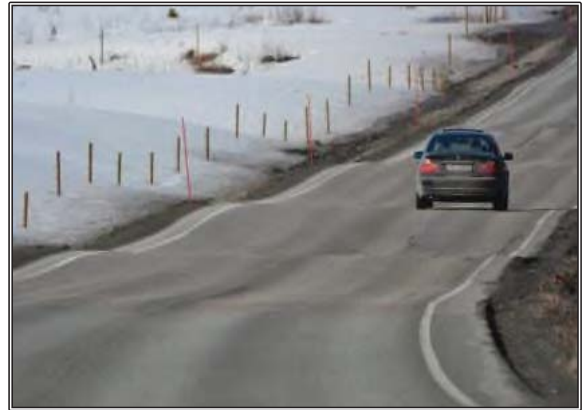
Şekil 3.11. Kabarma veya Şişme (Upheaval or Swelling)
