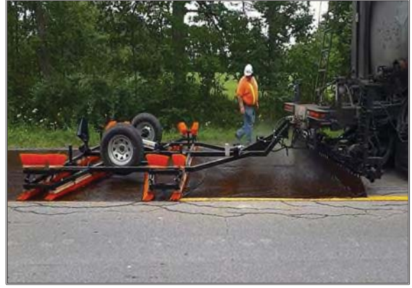
Şekil 6.8. Fırçalamayla Yalıtım (Scrub Seal) Uygulaması
