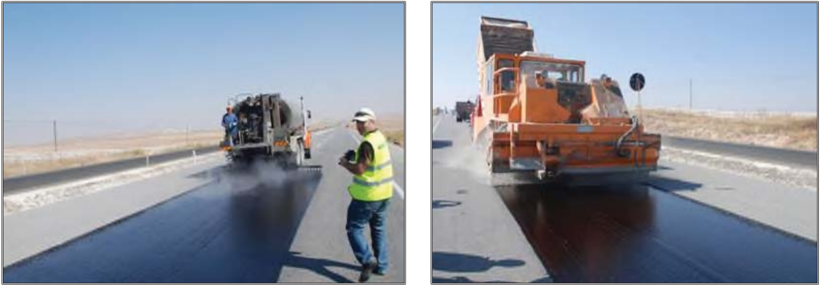
Şekil 6.6. Bitümlü Koruyucu Sathi Kaplama (Seal Coat) Uygulaması
