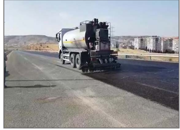
Şekil 6.19. Harç Tipi Kaplama Uygulaması Öncesinde Çatlak Tamirâtı ve Tack Coat Uygulaması
