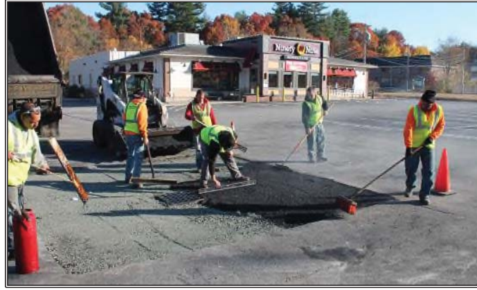
Şekil 5.11. Yamada Yüzey Düzgünlüğünün Kontrol Edilmesi
