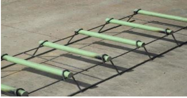
Şekil 7. Örnek kayma demiri yerleşimi
