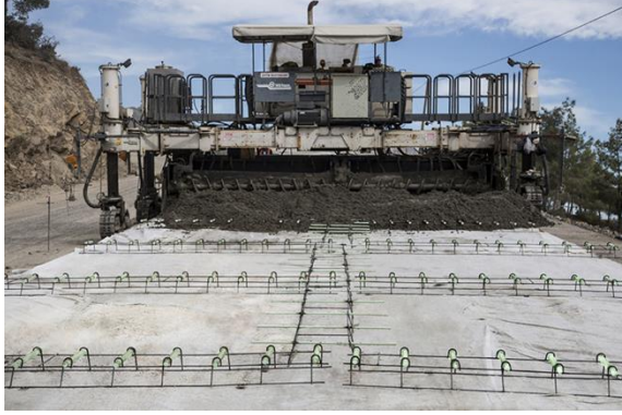
Şekil 9. Beton dökümünden önce kayma demiri sabitlenmesi
