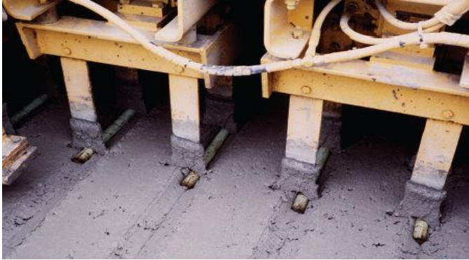
Şekil 10. Otomatik kayma demiri yerleştirilmesi
