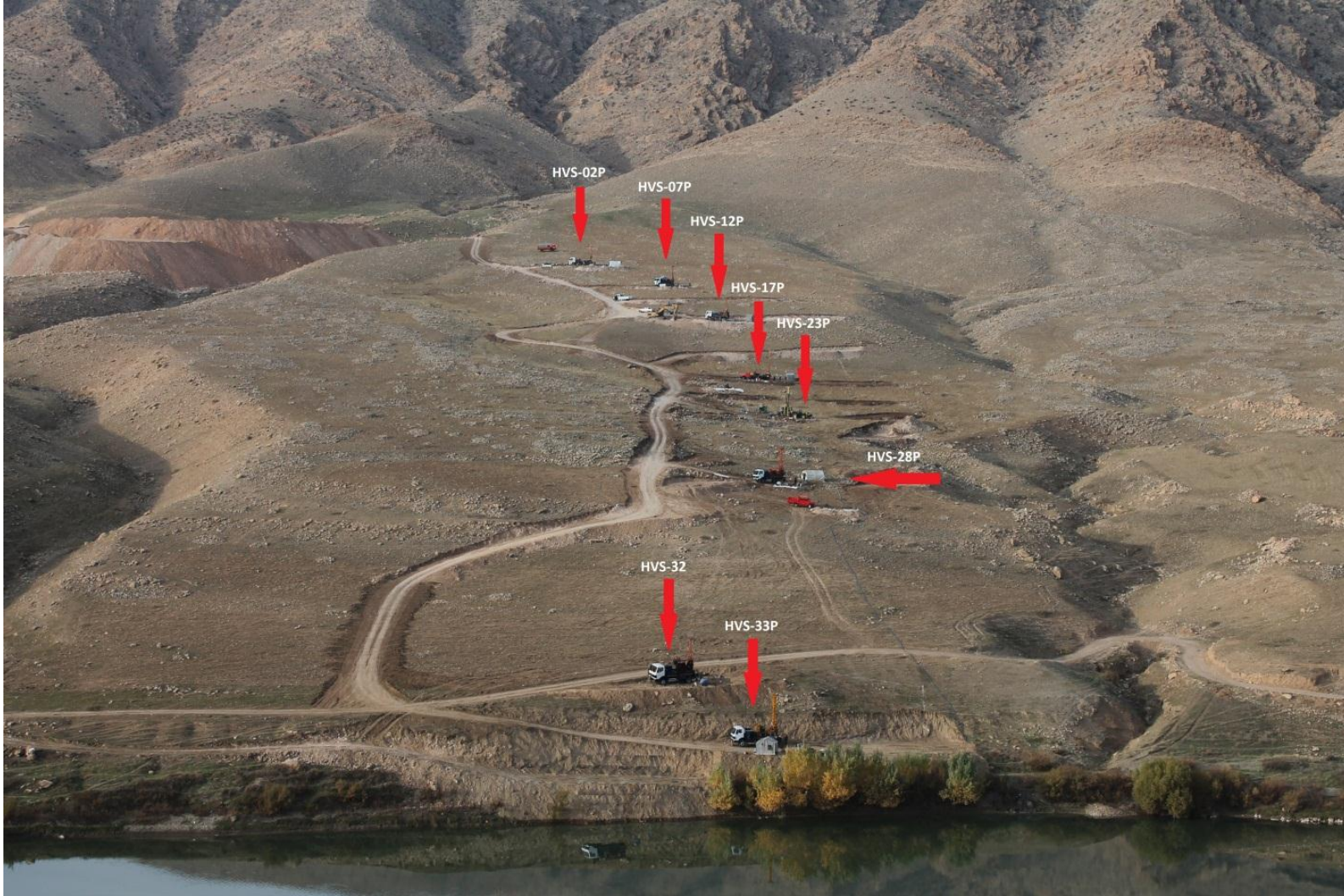
Batman – Mardin Devlet Yolu Km:35+100-35+500 Arası Hasankeyf Viyadüğü Heyelanı
