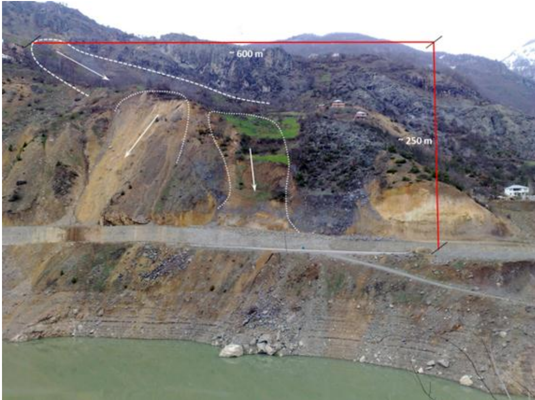
Şekil-12: Tirebolu-Torul Devlet Yolu (877-02) Km:30+000 Süme Heyelanı (karmaşık yapıda ardışık gelişen dairesel kayma şeklindeki heyelan örneği).
