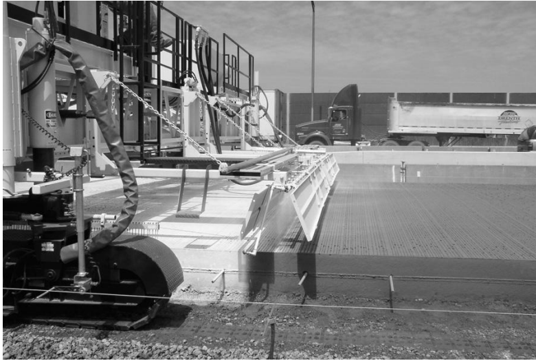
Resim 6.10 Kimyasal Kür Uygulamasının Araç ile Yapılması
