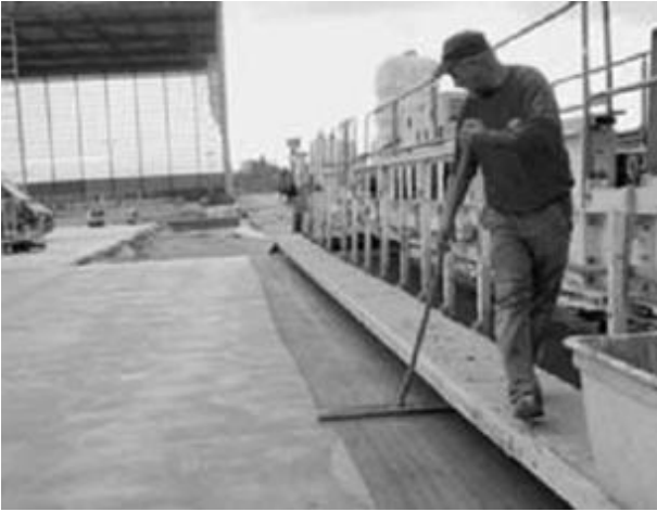
Resim 6.2 Fırça ile Enine Yüzey Dokulandırma
