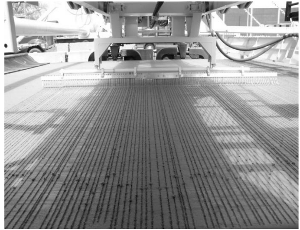
Resim 6.3 Araç ile Yapılan Enine Yüzey Dokulandırma
