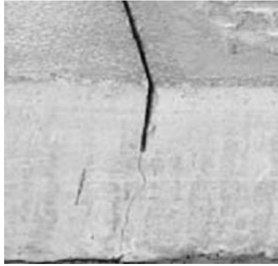
Resim 6.8 Planlanan Çatlak ile Birlikte Enine Büzülme Derzleri
