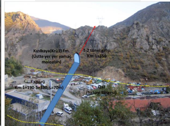
T2 Tünel girişi ve öncesindeki köprü yeri.
