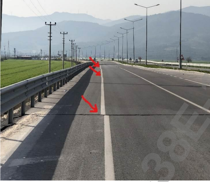
Deprem Nedeniyle Üstyapıda Oluşan Hasarlar
