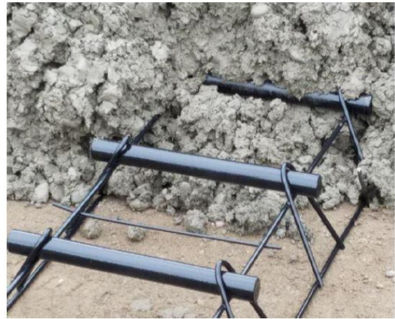
Sehpa Üzerine Yerleştirilmiş Kayma Donatıları (Epoksili Düz Demir)
