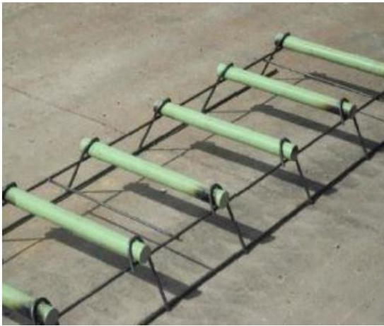
Sehpa Üzerine Yerleştirilmiş Kayma Donatıları (Epoksili Düz Demir)
