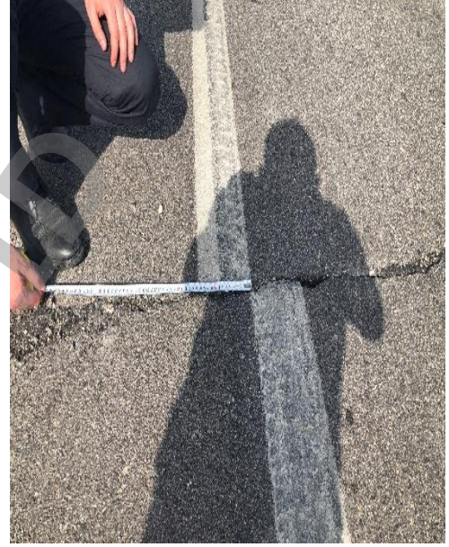
Deprem Nedeniyle Üstyapıda Oluşan Hasarlar
