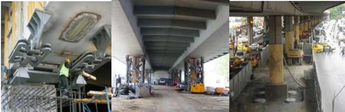
Sismik Takviye Çalışmaları
