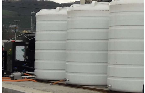
Resim 5. Osmangazi Köprüsü Tuzlu Su Hazırlama Ünitesi
