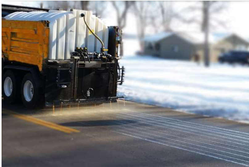
Resim 4. Buzlanma öncesi (Anti-icing) çözelti uygulaması
