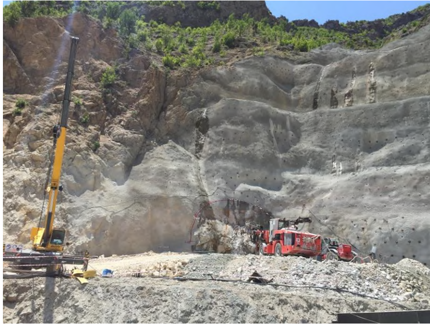
T-39 tünelinin revize portalininin destekleme çalışmaları
