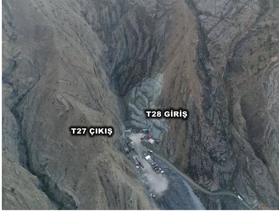
Sahada gerçekleştirilen portal imalat çalışmaları
