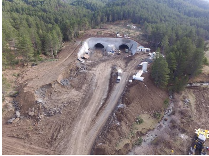
Tünel giriş portalinden görünüm
