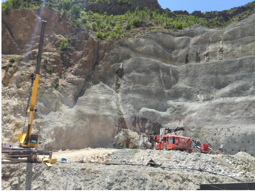
T-39 tünelinin revize portalininin destekleme çalışmaları
